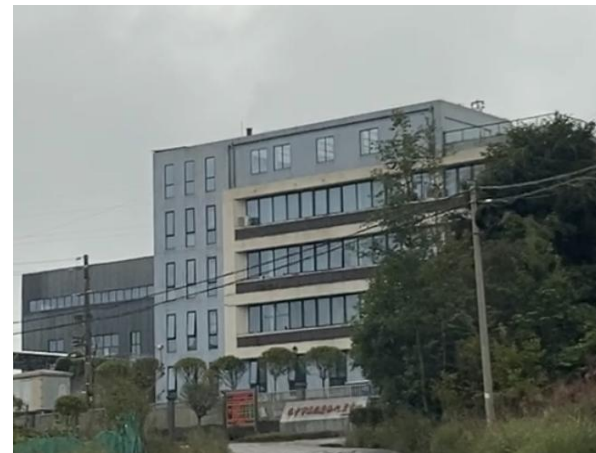
北侧循环经济企业孵化园
