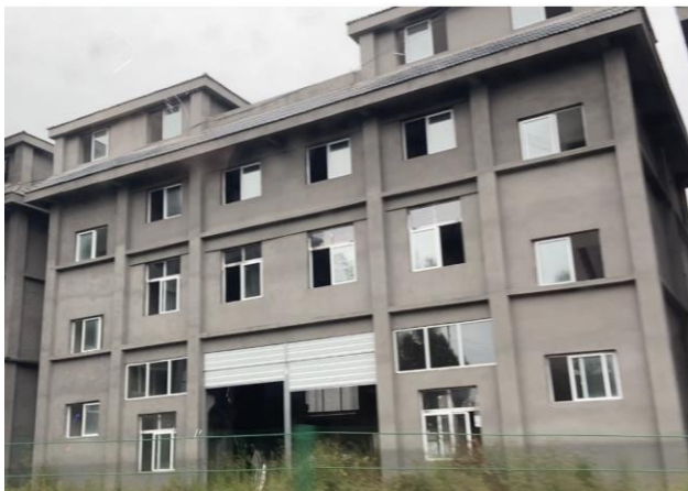
北侧循环经济企业孵化园
